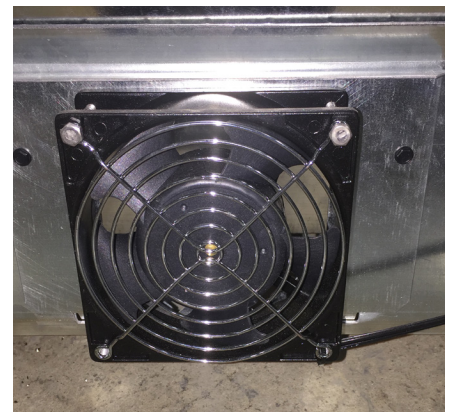
Defogger Blower Discharge
